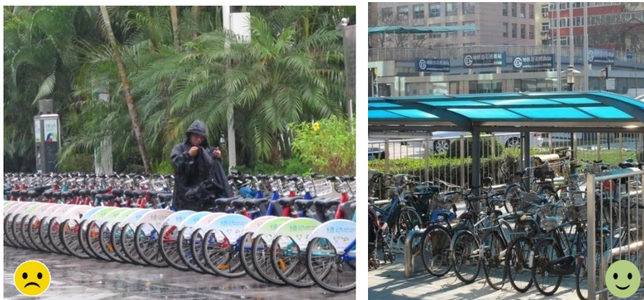
图 9.3.4 自行车停车场设置雨棚反例与正例
