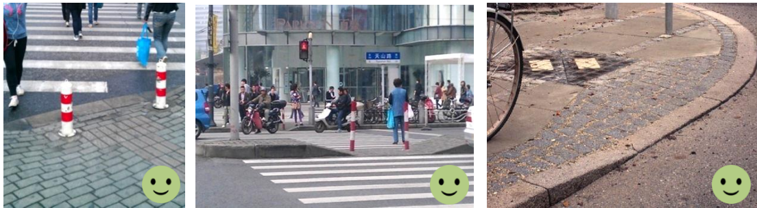
图 5.4.2 路缘石缓坡处理正例
