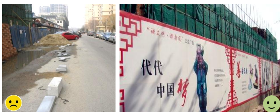
图 6.5.5 施工围挡反例与正例
