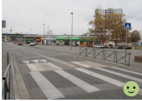
图 12.5.2-2 交通稳静化措施正例（左，减速带；右，减速拱）
