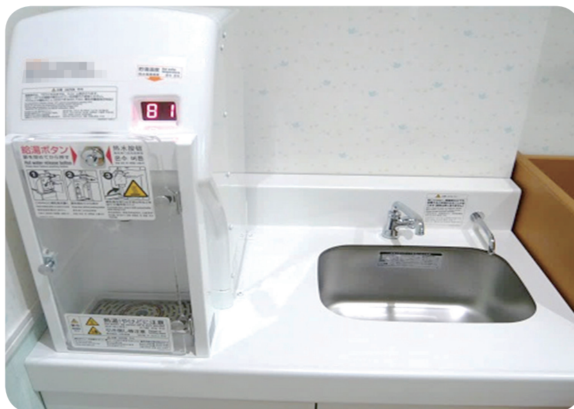
图 D.11-3 日本青森机场 台面式直饮水机，可提供热水，配有安全门
