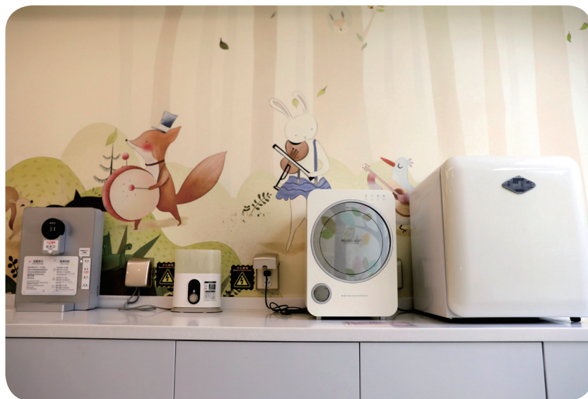
图 D.4-1 北京大兴国际机场 多功能母婴室备餐区提供饮水机、温奶器、消毒机、冰箱，并在设施旁贴有使用说明
