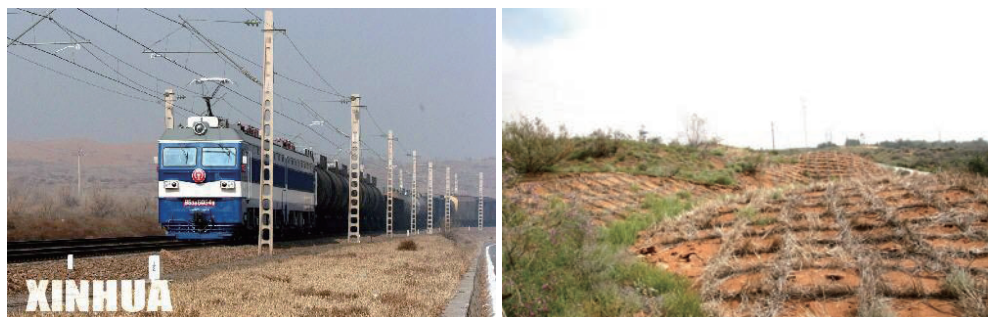
图 183 铁路沙害治理成效
