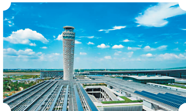
青岛胶东机场太阳能光伏发电项目
