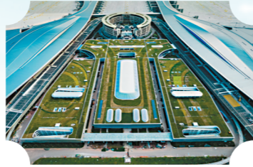
天府机场 实现全场100%绿色建筑
