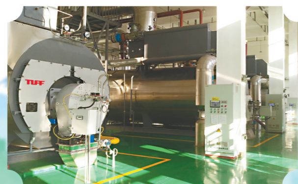
哈尔滨机场锅炉煤改气
