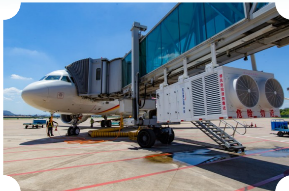
杭州机场 APU 替代设施
