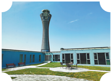
首都机场东区机坪管制塔台 装配式“零碳”建筑
