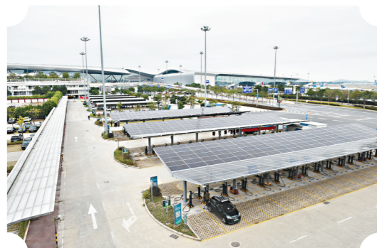
广州白云机场光伏充电项目
