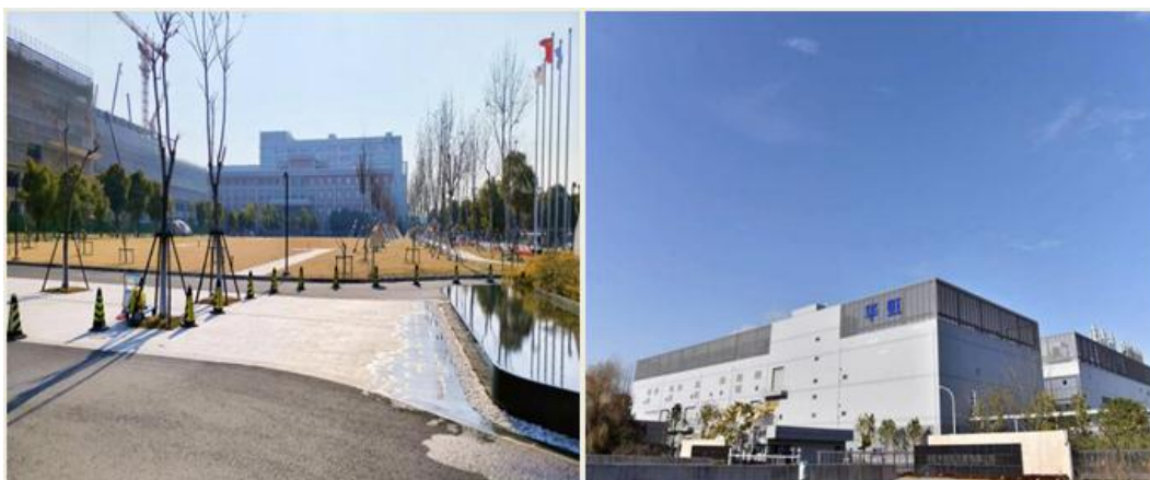
图4 华虹无锡产业园现场照片
