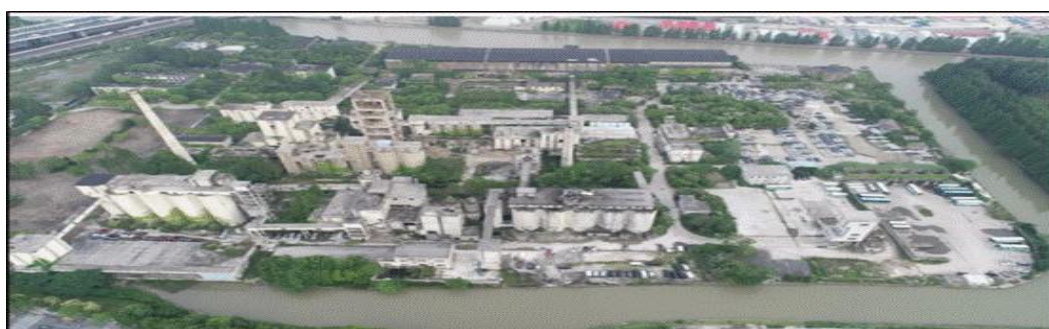
张江水泥厂项目改造前实景图
