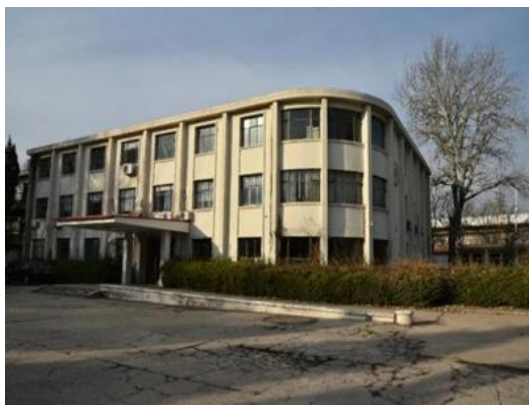
天津第一机床厂经营楼修缮前
