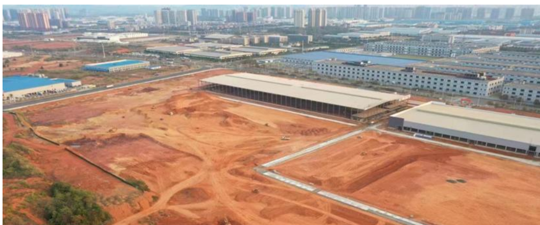
图2 全新智能LCV项目施工现场照片
