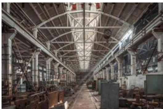
改造前的旧厂区
